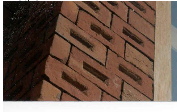
Klamp gelijmd metselwerk
