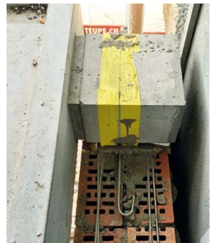
Oplegnok balkon bij het project Freilager (CH)
