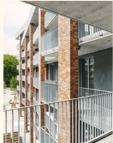
De galerijen worden volledig gedragen door metselwerk bij project Freilager
