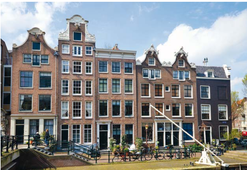
Eeuwenlang vervulde de massieve baksteengevel zowel de afsluitende, bouwfysische als de dragende functies
