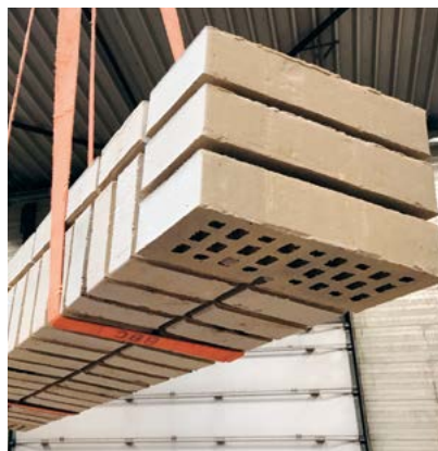
Prefab gelijmde metselwerklatei
