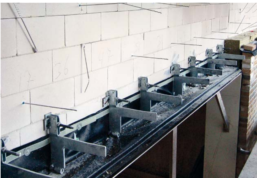
Geveldragers en spouwankers zijn niet aanwezig bij Brick-BENG
