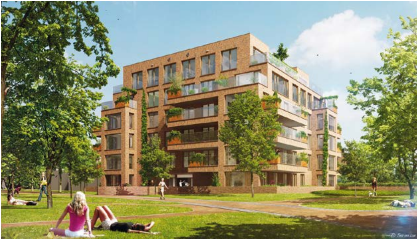
Basis voor het onderzoek vormde bouwproject Willemspoort, Den Bosch
