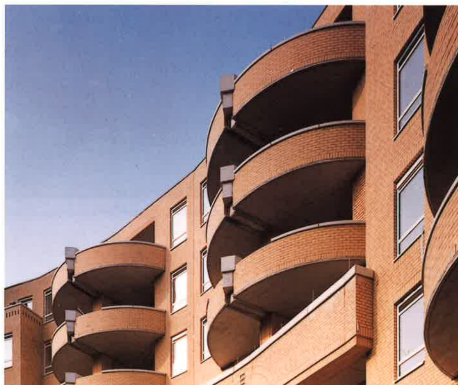
De Heuvelgalerie te Eindhoven, Walter Brune Consulting
