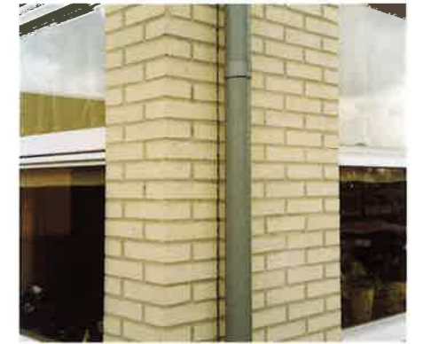
Metselwerkdilatatie achter HWA
