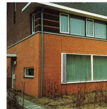
Dilatatie zelfdragende latei met onvoldoende stijfheid
