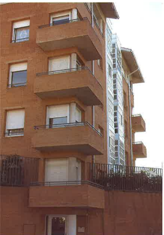
Figuur 16 Opgemetselde balkonafdeling (foto: Grid Design).
