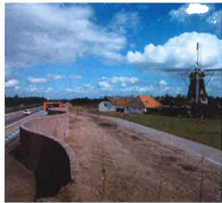
Figuur 9 Geluidsmuur met gebogen vorm.
