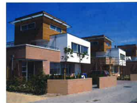
Figuur 36 Muurafdekkingen. Tuinmuur afgedekt met rollaag, dakterras afgedekt met prefab afdekprofiel. (Foto: Grid Design)
