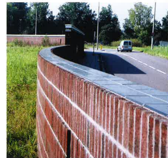
Figuur 20 Geluidsmuur in Amstelveen, ontworpen door Kruunenberg Van der Erve Architecten uit Amsterdam.
