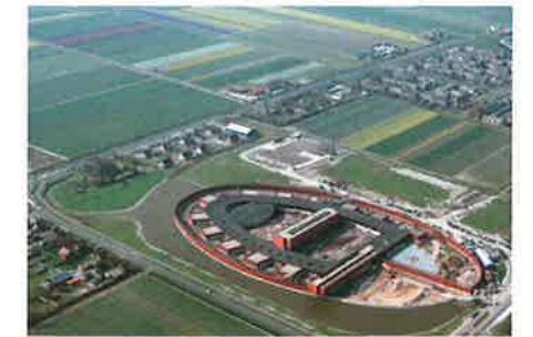
Figuur 14 Vrijstaande muur van ca 5 m hoog rond het complex van de RIJ 'De Doggersbank' in Den Helder. De muur is vervaardigd van gelijkde bakstenen. Architect: Loof & van Stigt architecten B.V., Amsterdam. Foto: Snow-White fotografie / Moniek Mulder, Weesp.
